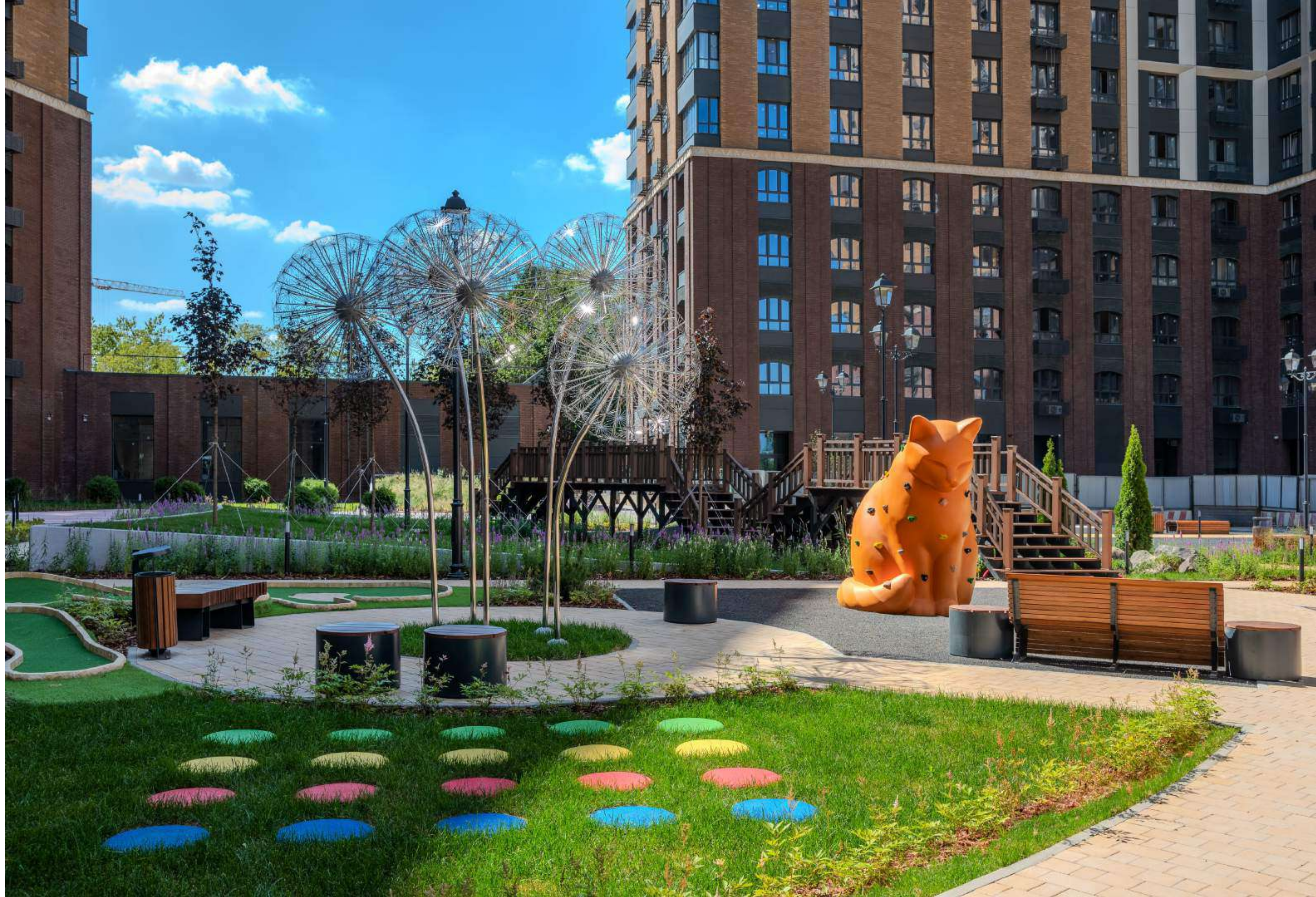
Фотография. Благоустройство двора 1 и 3 корпусов. 2024
